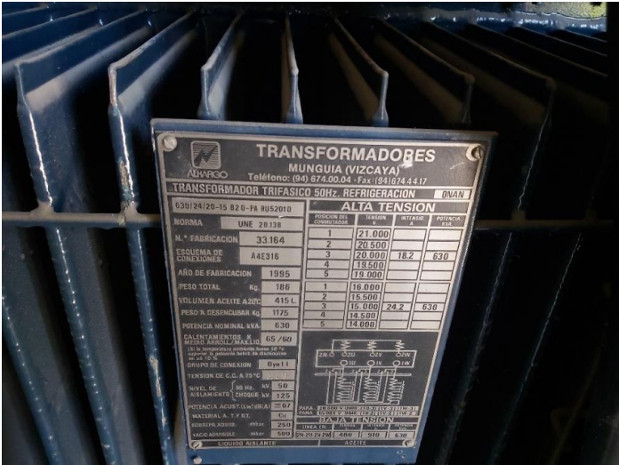
Placa de Características de Transformador existente
