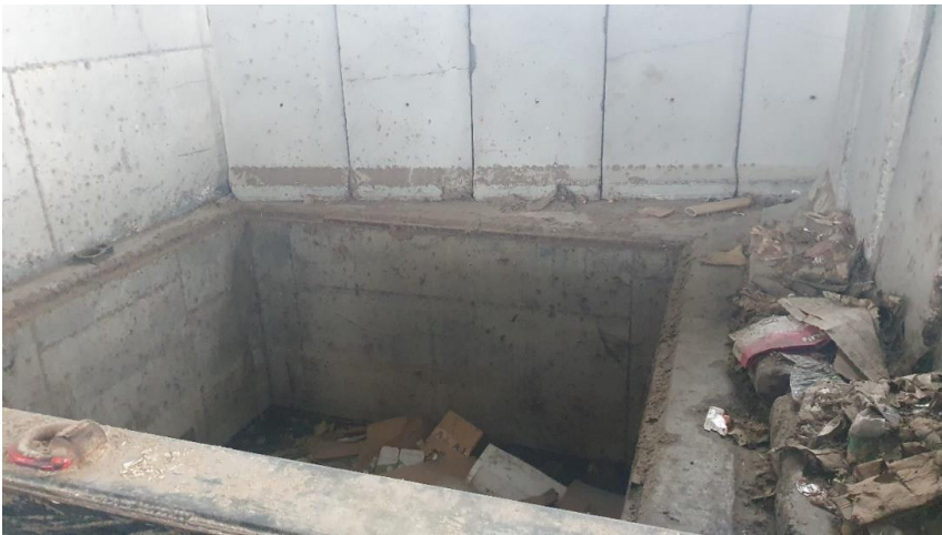
Vista de las instalaciones de la nave de Tratamiento II. Detalle del foso a hormigonar en la situación reformada.
